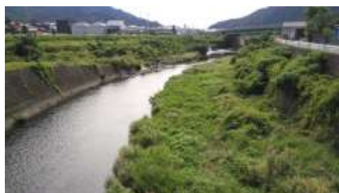
▲もとより防災が最重要課題である一方、都市河川として環境向上が望まれる。水辺に近づくこともできず、眺めるだけのいびつな環境は、むしろストレスを生み、愛着がわきにくい。
