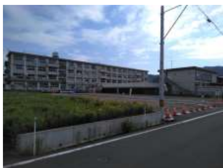
▲今年、小学校の近く、公民館の西隣の宅地造成がいつの間にか完了(4.5.7)。
