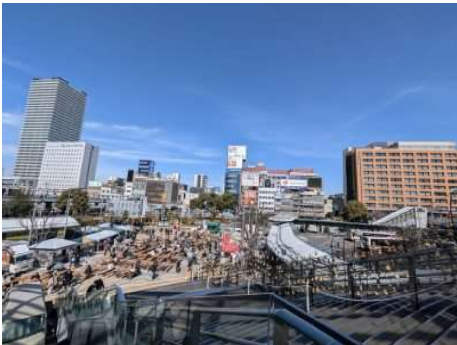
▲岐阜駅北口の景観。再開発ビルは、真ん中両端に位置
